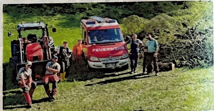
An zwei Tagen wurde ein Wildbachabschnitt auf einer Länge von rund 270 Metern von potenziellen Verklauungs-Gefahren befreit. Klar! Ennstal/Natalie Prügler
